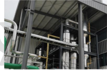
惠州贤丰新材料有限公司 氯化锂溶液 3T/H MVR 蒸发器 2套
