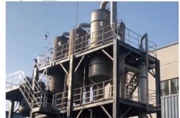
广东华肽生物科技有限公司 蛋白肽水溶液浓缩项目 2T/H 三效蒸发器 1套
