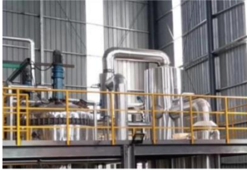
江西俊亚实业股份有限公司 化工废水 2T/H MVR 蒸发器 1套+4T/H MVR 蒸发器 1套
